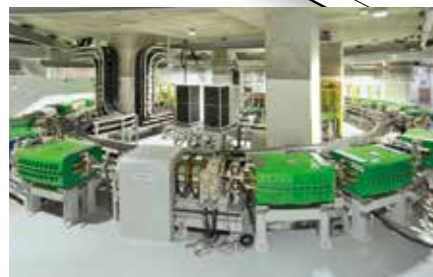
地下1F 加速器室
