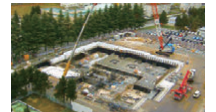
2017年11月の建設現場の様子
