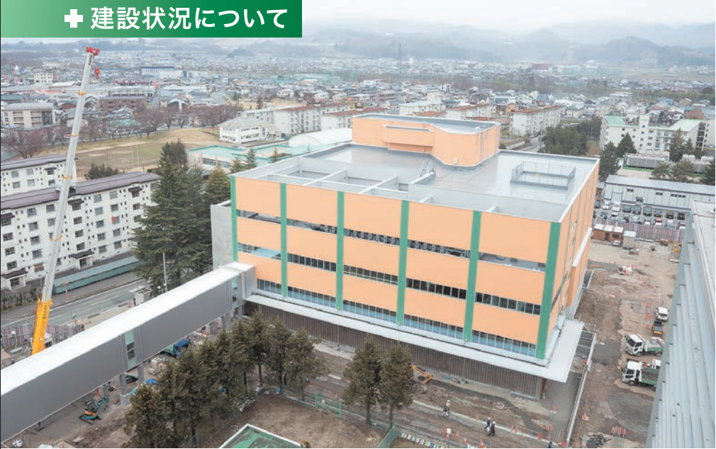
建設現場の様子
